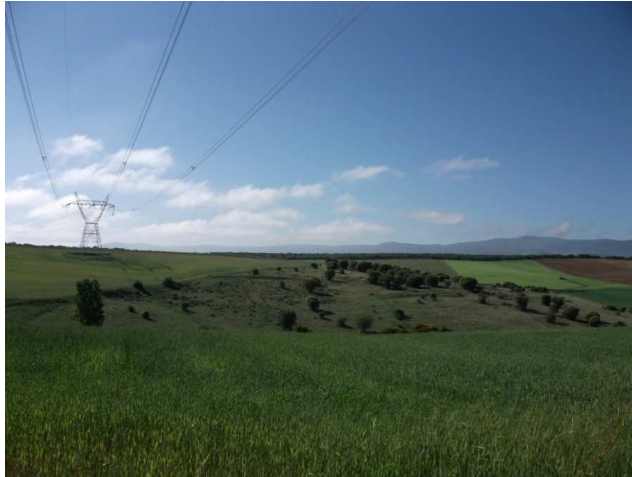
Figura 22. Vista tendido aéreo
